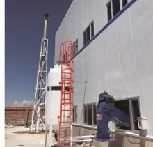
河南项目 Henan Project
